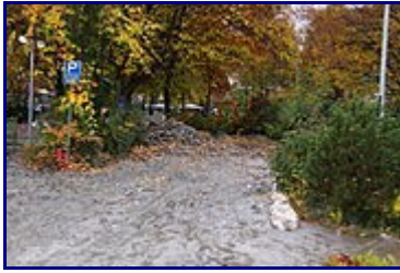
Bohrstelle auf Parkplatz
