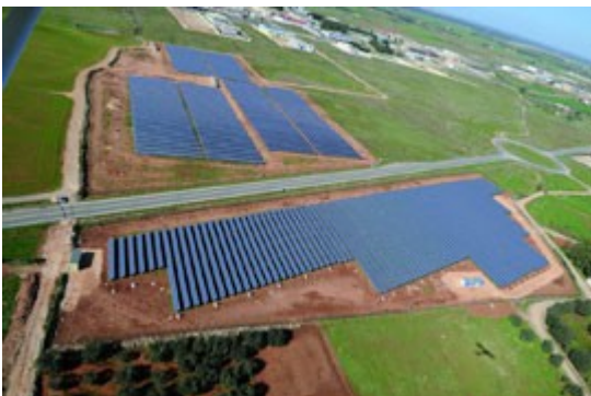
Photovoltaik-Kraftwerk in Apulien (Italien. SunEdison)
